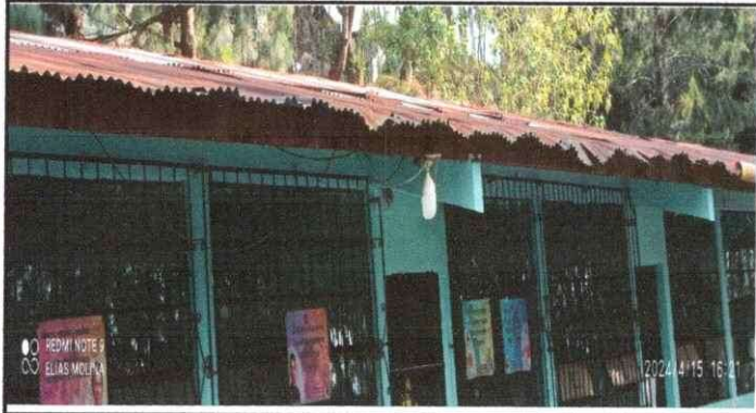
Foto 1: Sustrucción de láminas por deterioro
