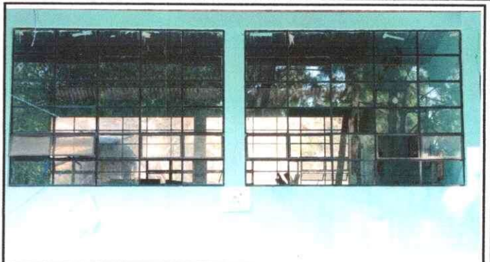
Foto 2: Colocación de Balcones área de Biblioteca
