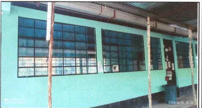
Foto 4: Colocación de Balcones en el salón de segundo básico
